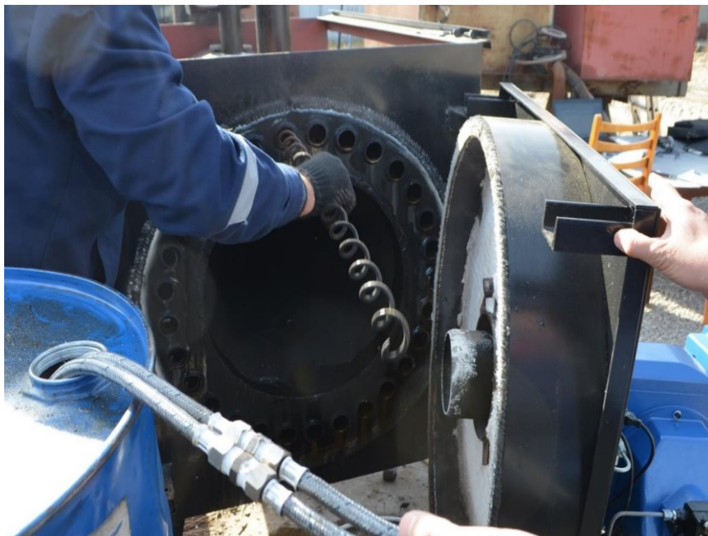
Рисунок 3.5 – Вид котла ВВ-400 с фронта на камеру горения, образующую реверсивное движение факела с конвективными трубами со спиралевидными вставками
