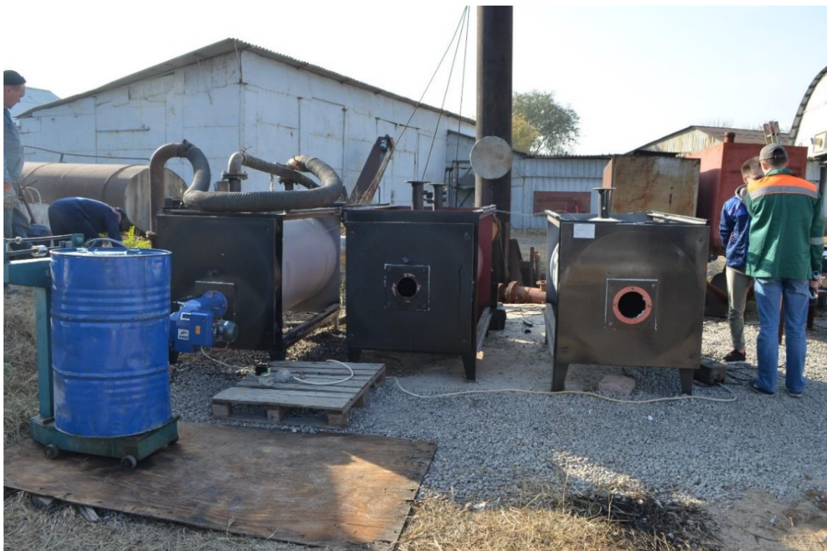
Рисунок 3.9 - Общий вид водогрейных котлов ВВ-400, КВа-400 и КВа-500 в период подготовки испытаний на комплексном специальном стенде ТОО «Казкотлосервис» [73]
